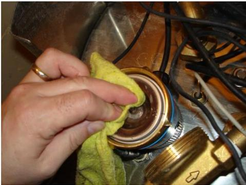
Le boîtier de la pompe doit également être nettoyé. Une fois nettoyée, replacer la tête du rotor dans le boîtier.
