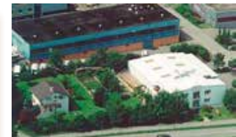
Achat du bâtiment industriel bleu en 1996
